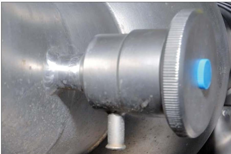
Abb. 1: Ist das Probenahmeventil falsch montiert oder ist es die falsche Ausführung für den Einbauort?
